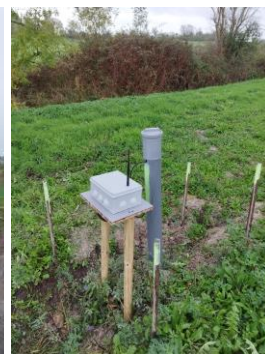
Piezomètres disposés autour de futurs travaux de restauration morphologique (Empuré)
